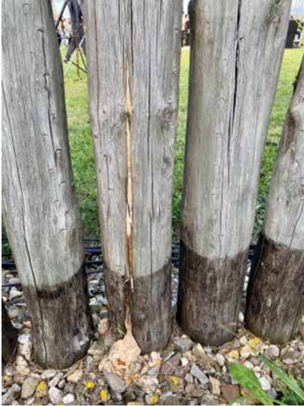
Abb. 2. Einzelne Pfosten der 2010 erneuerten Rekonstruktion der Anlage von Goseck weisen rund 14 Jahre nach ihrer Errichtung trotz modernen Holzschutzmaßnahmen erneut Pilzbefall auf (Foto N. Henkel aufgenommen am 02. September 2023)
